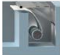
Gemauerte Nische mit Führungsschienen und Terrassenabdeckung
